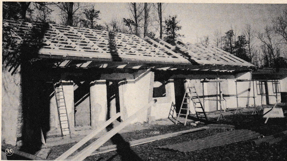
Bild 35 zeigt die Umkleidekabinen auf dem Sportplatz zu Beginn der Umbauarbeiten im November 1995.
